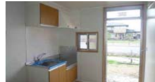
※応急仮設住宅の建設状況
