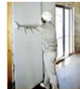
耐震パネル施工
