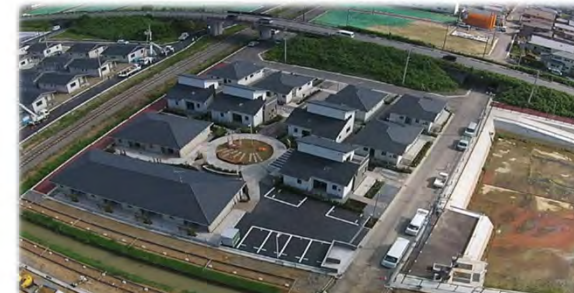
復興公営住宅(宮城県石巻市)
