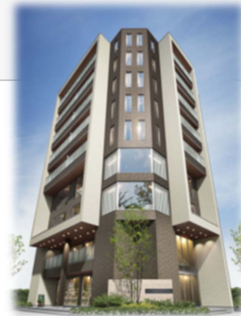
9階建多層階住宅「ビューノ9」
