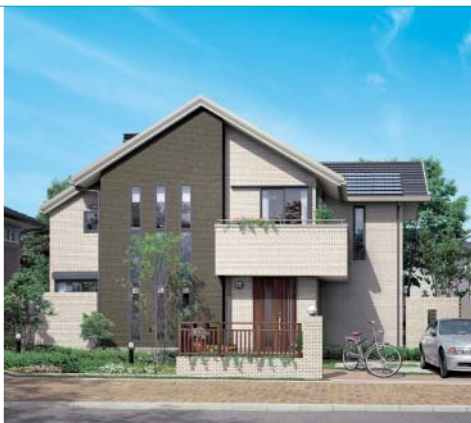
エルソーラナ (積雪寒冷地住宅) ソーラー発電を搭載した「あったかエコライフ住宅」。
