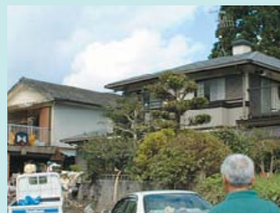
被災されたお客様宅の復旧を支援
