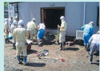
支援スタッフによる清掃作業
