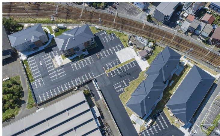
ドローンによる空撮写真
