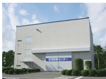
住宅試験センター(滋賀県・湖東工場)
