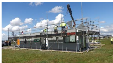
建築中の様子
