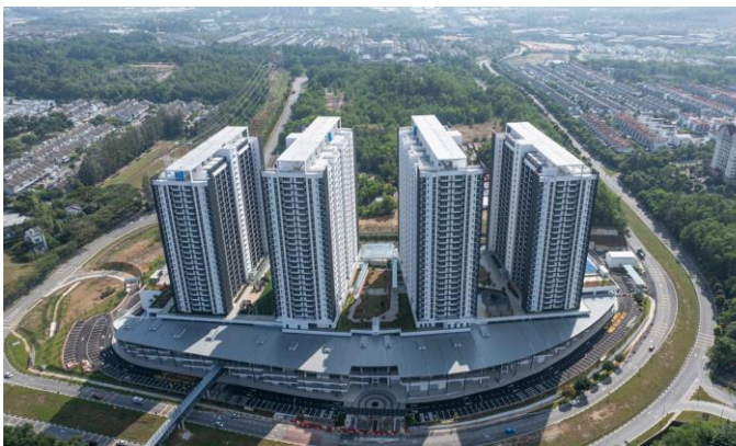
マンション外観(空撮)
