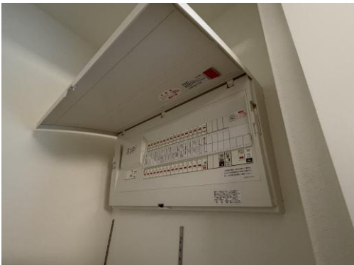
視察対象となった分電盤・感震ブレーカー 実機(LDK 収納内の壁面に設置)
