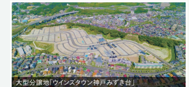
大型分譲地「ウインスタウン神戸みずき台」
