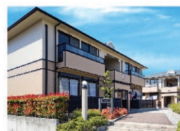
外壁塗り替え
