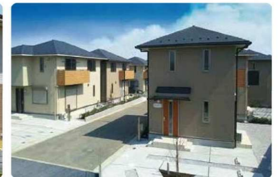
狭山市 12棟 2017年3月竣工
