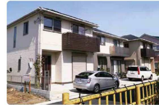
朝霞市 3棟 2016年2月竣工
