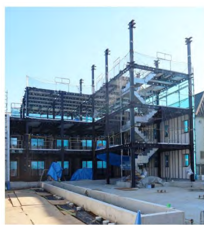
重量鉄骨構造現場イメージ
