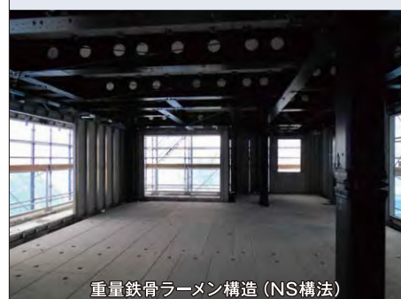
重量鉄骨ラーメン構造 (NS構法)
