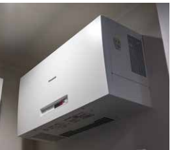
太陽光発電システム (パワーコンディショナー) 万一の災害時にも電気の確保が可能。 パワーコンディショナーには非常用の コンセントがあり、停電時でも電源と して使用可能です。
